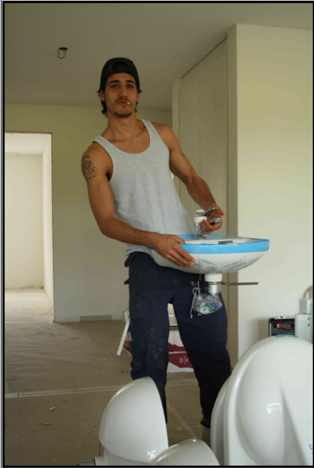
Ambitionierter Sanitärmeister im Begriff einen Apparat zu montieren
