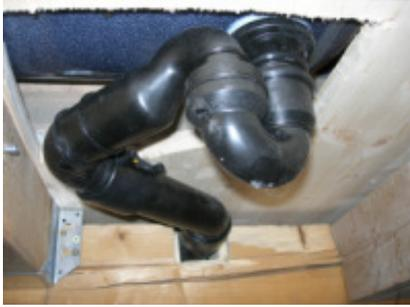
Danach stecke ich den Geruchverschluss an den Anschlussstutzen, und schliesse Den Geruchverschluss an den Ablauf an, anhand einer Steck oder Scheissmuffe.
