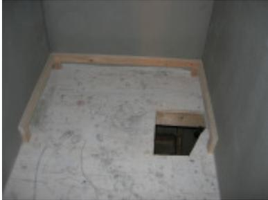
Ich messe die Tiefe der Duschewanne. Ich übertrage das Mass an die Wand. Bei Fermacell montiere ich Holzleisten an die Wand. Bei Bachstein nehme ich Niveo Dübel. Ich richte alles ins Blei.
