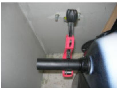
Dann montiere ich den Anschlussstutzen vom Geruchverschluss an die Duschewanne. Länge das Rohr ab.
