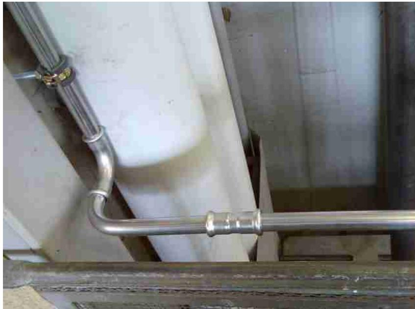
Wir mussten an fünf verschiedenen Stellen Druckluftanschlüsse (Bild) montieren.
