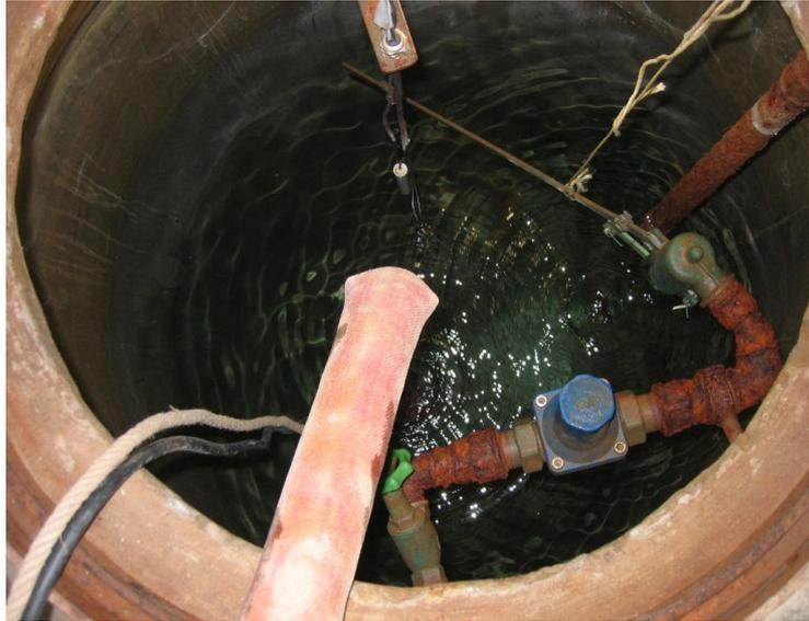
Als das Reservoir endlich leer ist, demontierten wir die alte Zuleitung, das Schwimmerventil und ersetzten es durch ein neues. Wir setzten das neue Schwimmerventil tiefer als das Alte, da die Fittings immer im Wasser waren und verrosteten.
