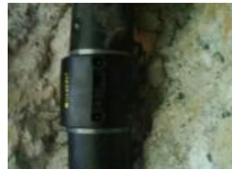
Danach die Elektroschweissmuffe mit dem Schweissgerätes anschweissen . Dieser Vorgang dauert ca. 1 ½ Minuten.
