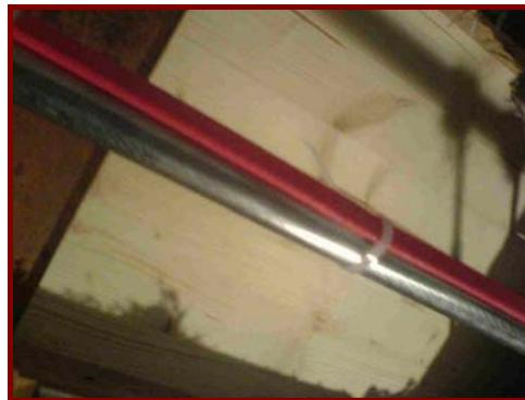
Das Begleitheizband kann entweder mit Gewebe-Klebeband oder mit Kabelbinder montiert werden. Bei den Kabelbindern darauf achten, dass der „Verschluss“ nicht direkt auf dem Heizband aufliegt.
