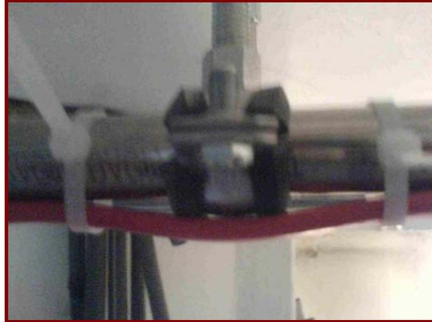
**Bei Bogen, wann immer es möglich ist, aussen herum fahren. So verhindert man eine Knickgefahr und fährt mit dem Begleitheizband automatisch die längere Strecke.**
