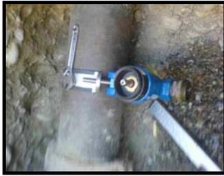
Der im nächsten Bild gezeigte Bohrer kann nun über das Gewinde im oberen Bild gedreht werden.
