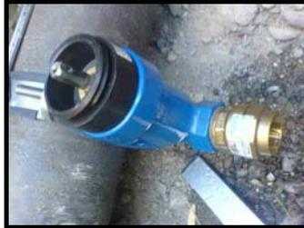
Zum Schluss kann die ganze Bohrvorrichtung entfernt werden. Mit einer entsprechenden Kupplung kann man dann die neue Leitung anschliessen. In unserem Fall wurde nur ein Wasserprovisorium angeschlossen.
