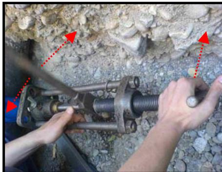
Hat man durch die Leitung gebohrt, so muss man den Bohrer durch drehen dieser Schraube befestigen.
