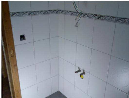
Zuerst zeichnet man die Bohrlöcher an. Ein Waschtisch montiert man normalerweise 85cm ab Boden. Auf Wunsch kann man den Waschtisch auch verstellen. Jetzt bohrt man die Löcher und schraubt die dazugehörigen Schrauben rein.
